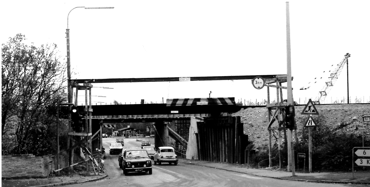
Ny bro over Fiskebækvej under bygning dec. 1972 (K9302)
