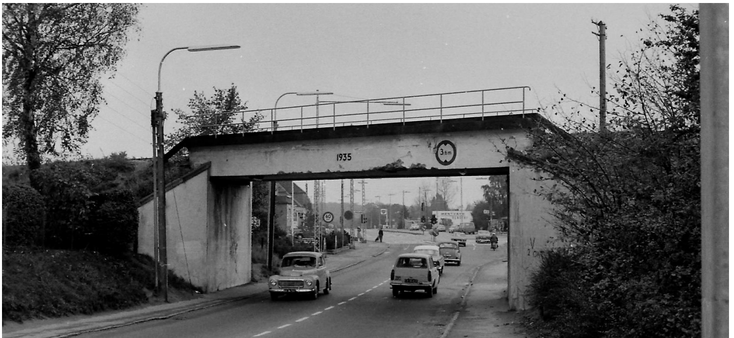
Broen over Fiskebækvej syd for stationen, som den så ud 9-10-1971 (K3437)
